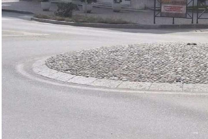
**Minirotatoria con isola centrale completamente sormontabile, realizzata con ciottoli in rilievo, in modo tale da arrecare disagio alle automobili che la percorrano**
